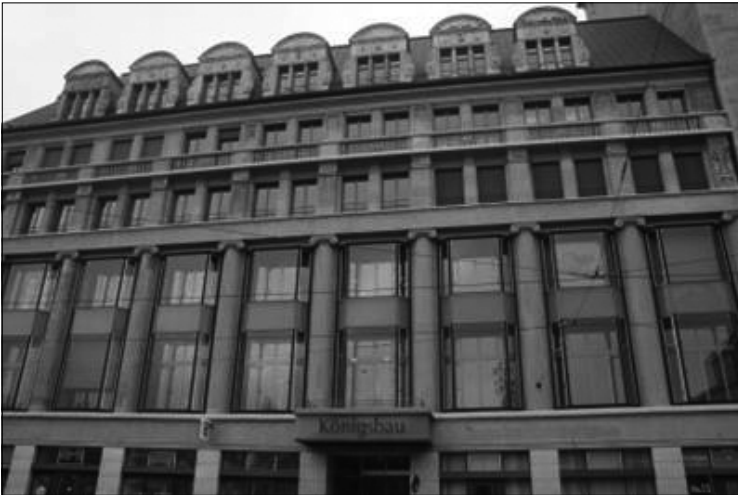
Ehemaliges Kaufhaus Hertz in der Goethestraße, am 9. November 1938 zerstört
